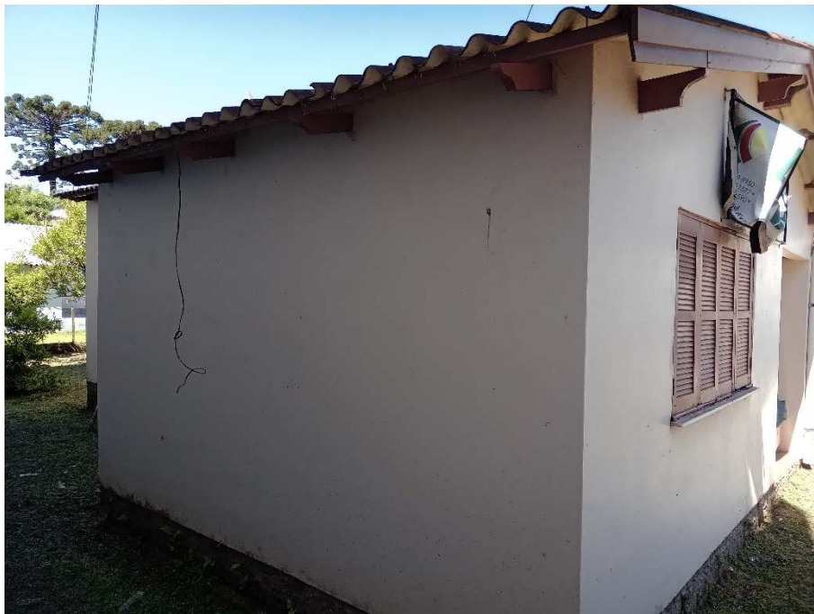
Foto 3 – Fachada a ser preparada para receber a pintura.
