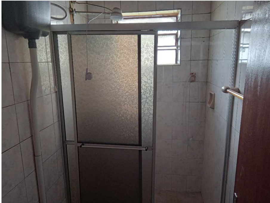
Foto 1 – Chuveiro a ser substituído.
