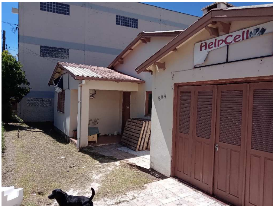
Foto 4 – Fachada a ser preparada para receber a pintura.
