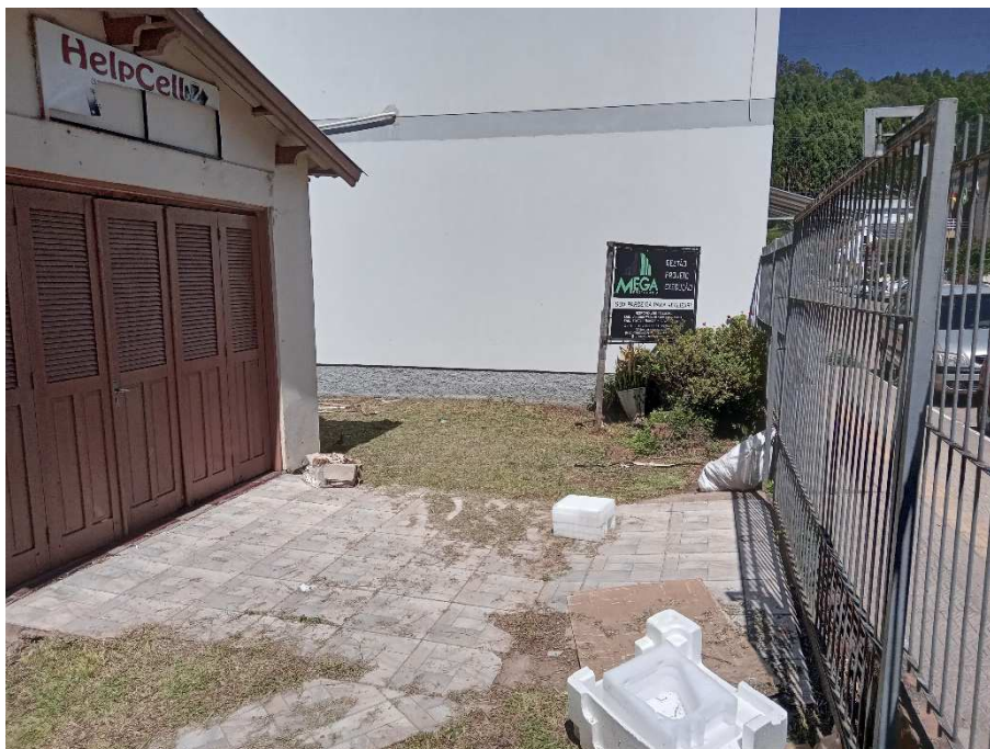
Foto 9 – Local a ser construída rampa de acesso a edificação.
