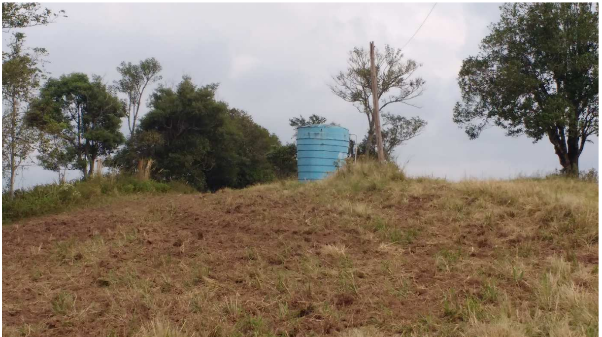
Foto 5 – Local da Instalação dos Reservatórios Superiores (coordenadas Lat. 29°27'17.41"S; Long. 52°38'8.77"O).
