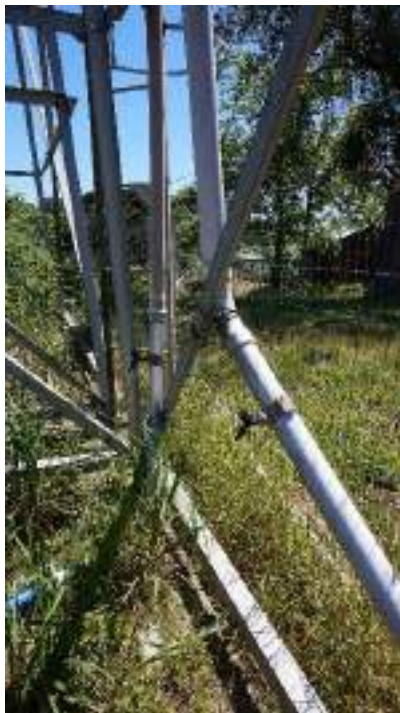
Figura 3.18 – Cercamento dos reservatórios da zona urbana
