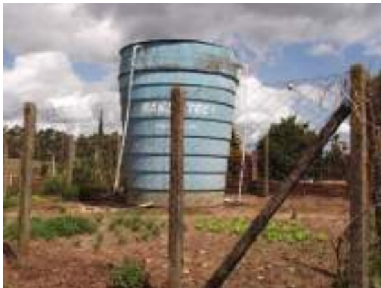
Figura 3.40 – Cercamento do Reservatório do SAA Linha Pinhal
