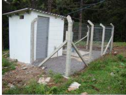
Figura 3.33 – Cercamento do Ponto de captação da Linha Fernandes 2
