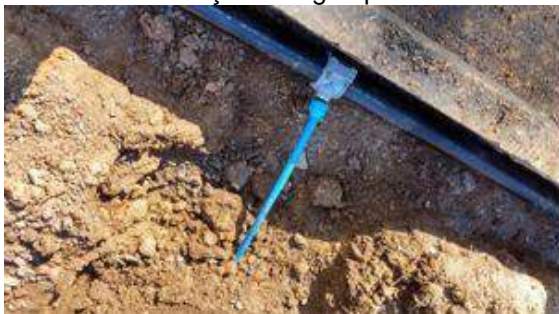
Figura 3.22 – Manutenção de rede de distribuição de água potável
