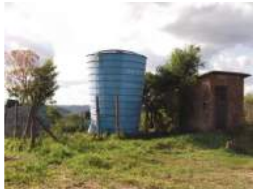
Figura 3.59 – Reservatório do SAA Linha Herval de Baixo
