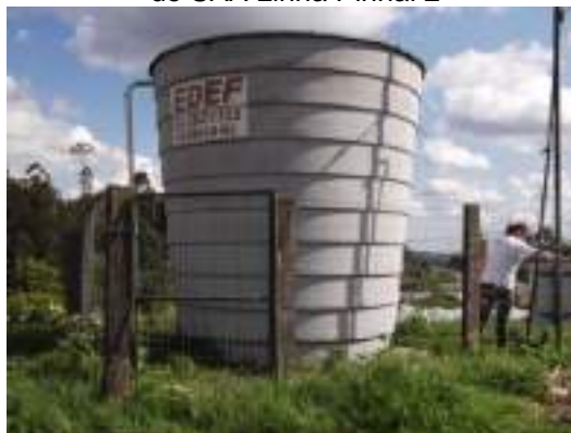
Figura 3.47 – Cercamento do Reservatório do SAA Linha Pinhal 2
