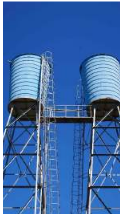
Figura 3.19 – Estrutura dos reservatórios da zona urbana
