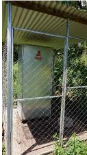
Figura 5.14 – Vista frontal do local de armazenamento temporário das embalagens
