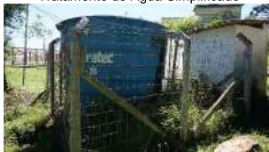
Figura 3.9 –Cercamento da Estação de Tratamento de Água Simplificado
