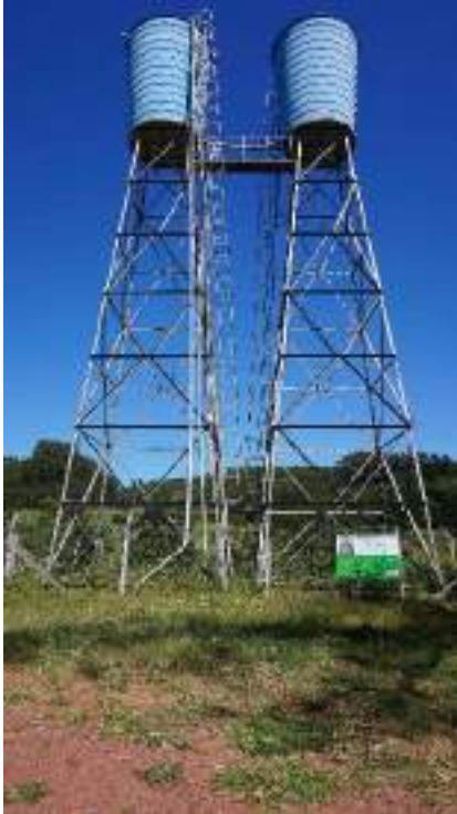
Figura 3.16 –Área dos reservatórios da zona urbana
