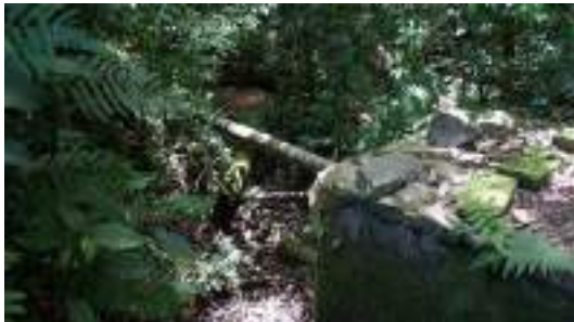
Figura 3.26 – Ponto de captação da Linha Fernandes
