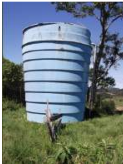
Figura 3.69 – Entorno do Reservatório do SAA Linha Cristina
