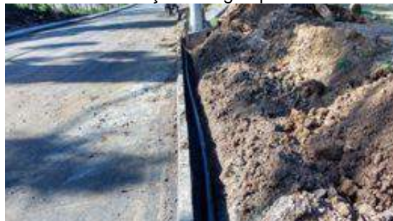
Figura 3.23 – Ampliação de rede de distribuição de água potável
