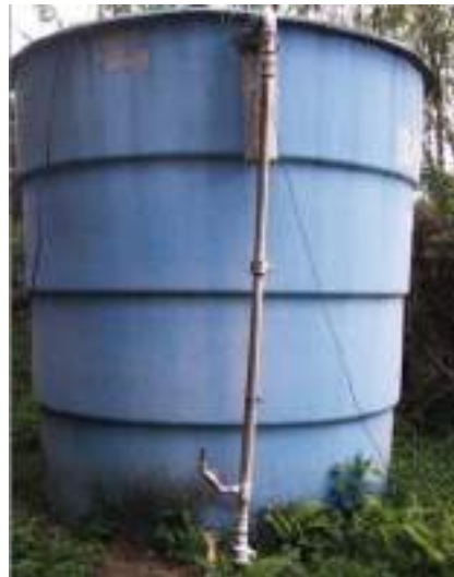
Figura 3.53 – Reservatório do SAA Linha Alto Marcondes
