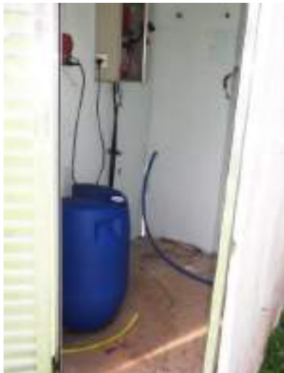
Figura 3.44 - Infraestrutura do local onde era armazenado a bomba dosadora
