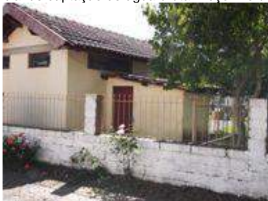
Figura 3.7- Manancial de captação de água bruta: Poço Profundo (Praça Pública)
