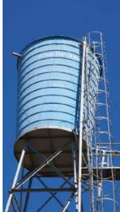
Figura 3.17 – Detalhe do Reservatório da zona urbana
