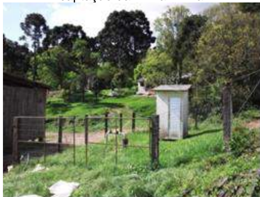
Figura 3.42 – Cercamento do ponto de captação da Linha Pinhal
