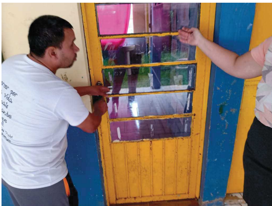
Foto 20 – Porta metálica a ser reformada (foto tirada em 03/02/2021).
