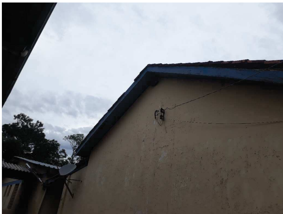
Foto 1 – Beiral da escola a ser reformado (foto tirada em 03/02/2021).
