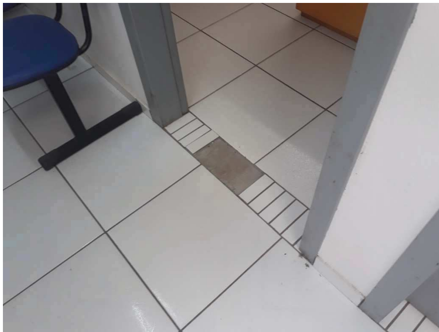
Foto 2 – Peça cerâmica a ser recolocada.
