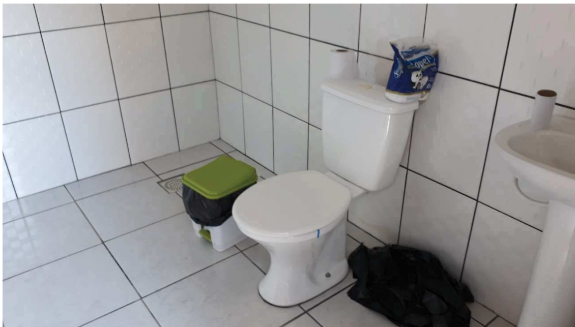
Banheiro a receber Box em vidro (foto tirada em 09/12/2019).
