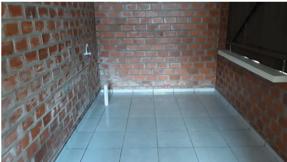
Paredes internas a serem revestidas (foto tirada em 09/12/2019).
