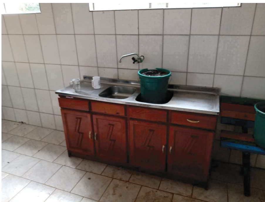
Foto 26 – Local a ser construída uma pia em alvenaria (foto tirada em 03/02/2021).
