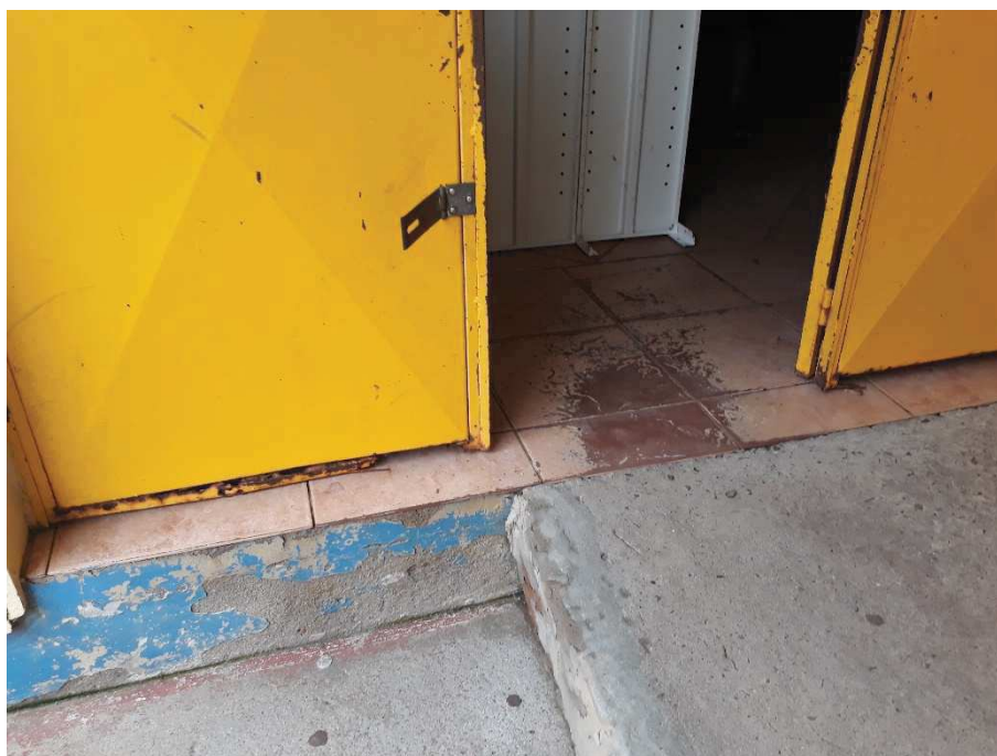
Foto 31 – Porta metálica a ser reformada (foto tirada em 03/02/2021).
