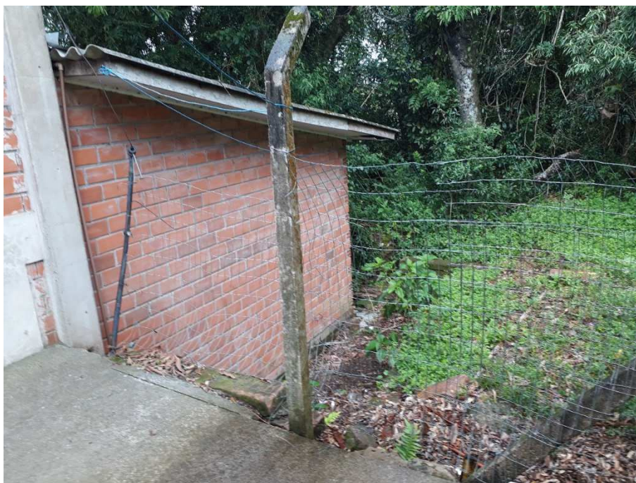
Foto 51 – Local a ser instalada nova tela metálica (foto tirada em 03/02/2021).
