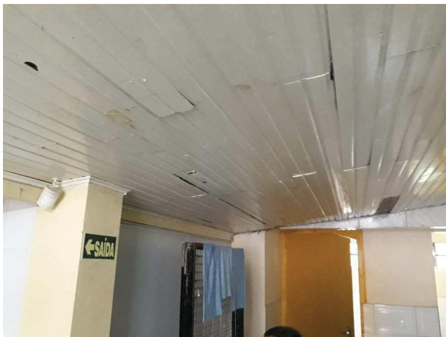
Foto 15 – Fôrro da escola a ser fixado (foto tirada em 03/02/2021).
