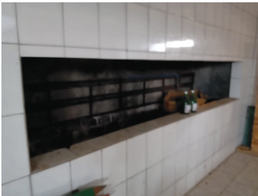
Foto 10 – Tampão para churrasqueira em “Divisórias Leves”.
