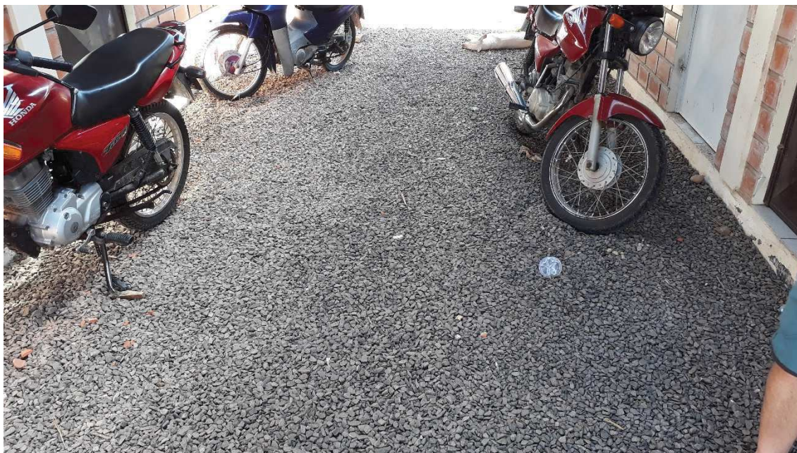
Local a ser executado o piso em lajotas de concreto (foto tirada em 09/12/2019).
