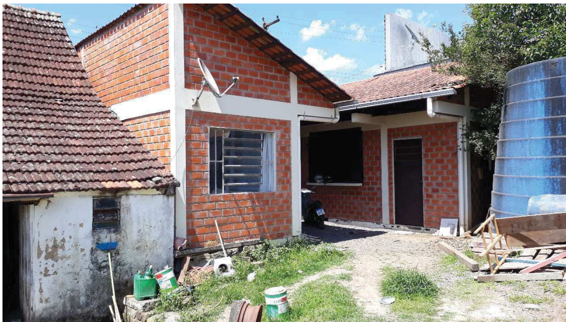
Cobertura em telha cerâmica (foto tirada em 09/12/2019).
