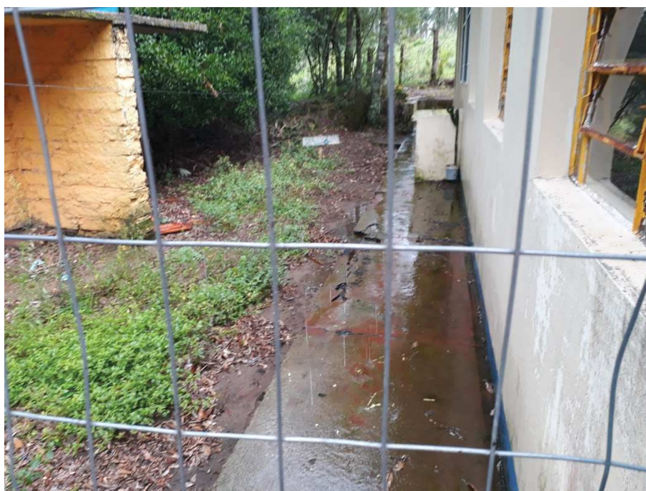
Foto 37 – Local a ser instalada a Caixa de Gordura em PVC e quebra em calçada a ser reformada (foto tirada em 03/02/2021).
