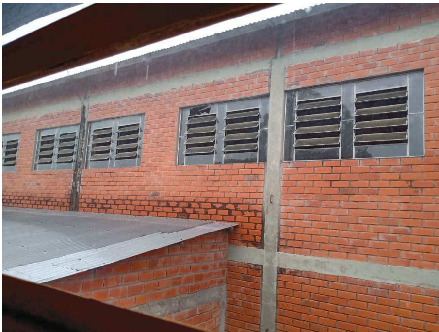
Foto 3 – Local a ser instalada novas calhas metálicas e “Algerosa” (foto tirada em 03/02/2021).
