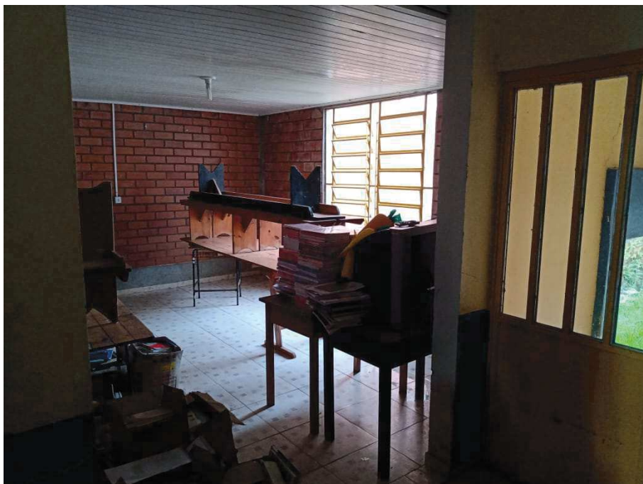
Foto 40 – Local a ser instalada porta de vidro (foto tirada em 03/02/2021).
