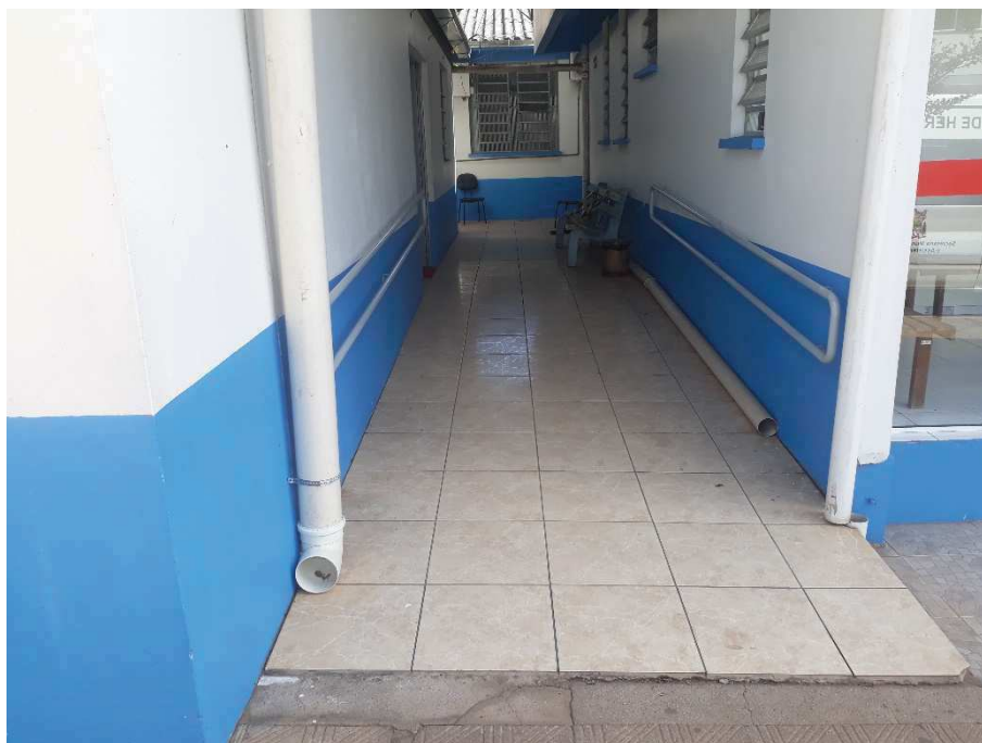
Foto 3 – Local a ser instalada nova tubulação pluvial.
