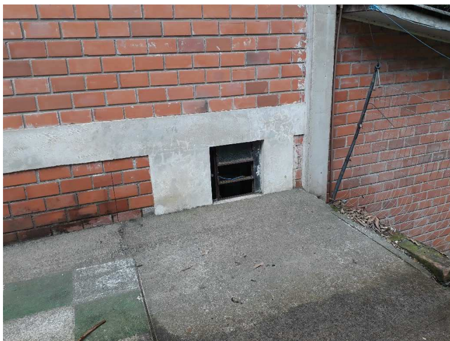
Foto 49 – Vidro do ginásio a ser repostado (foto tirada em 03/02/2021).
