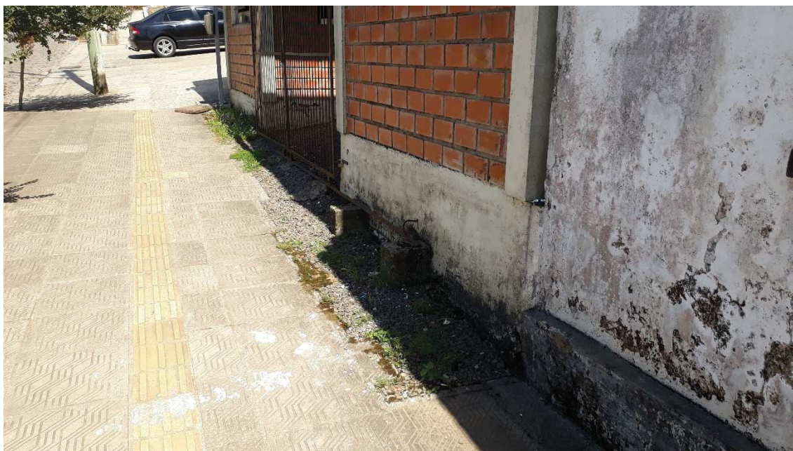
Local a ser executado o piso em lajotas de concreto (foto tirada em 09/12/2019).
