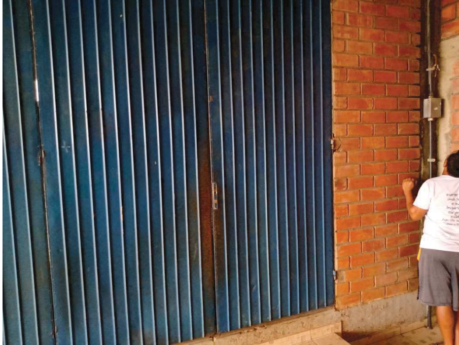
Foto 21 – Porta metálica a ser reformada (foto tirada em 03/02/2021).
