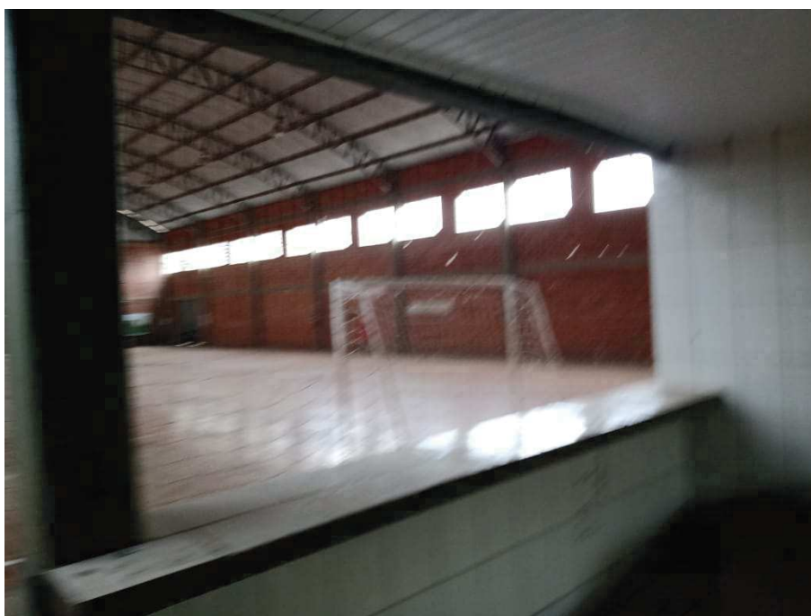
Foto 11 – Local para janelas “de correr” perfil de alumínio.
