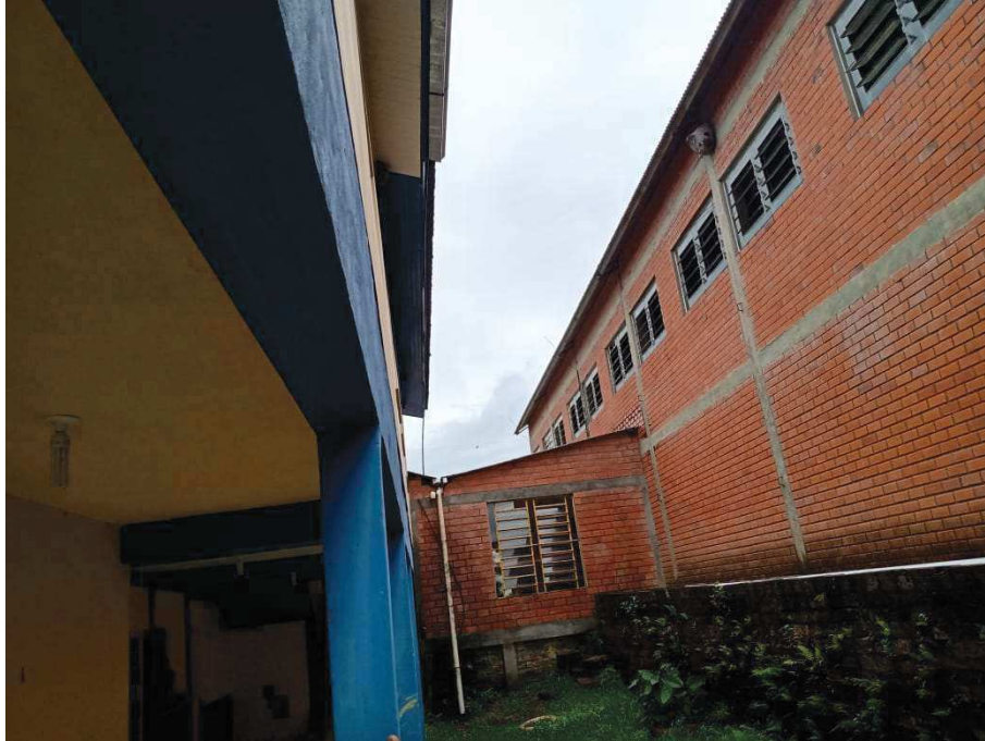
Foto 2 – Local a ser instalada novas calhas metálicas (foto tirada em 03/02/2021).
