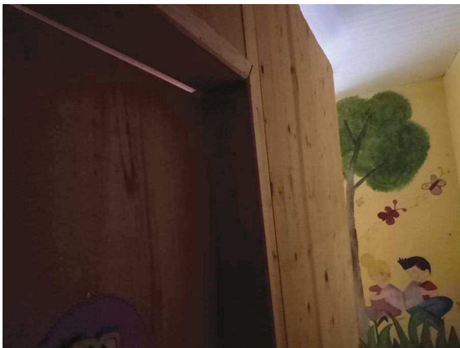
Foto 42 – Local a ser retirada as paredes em madeira (foto tirada em 03/02/2021).
