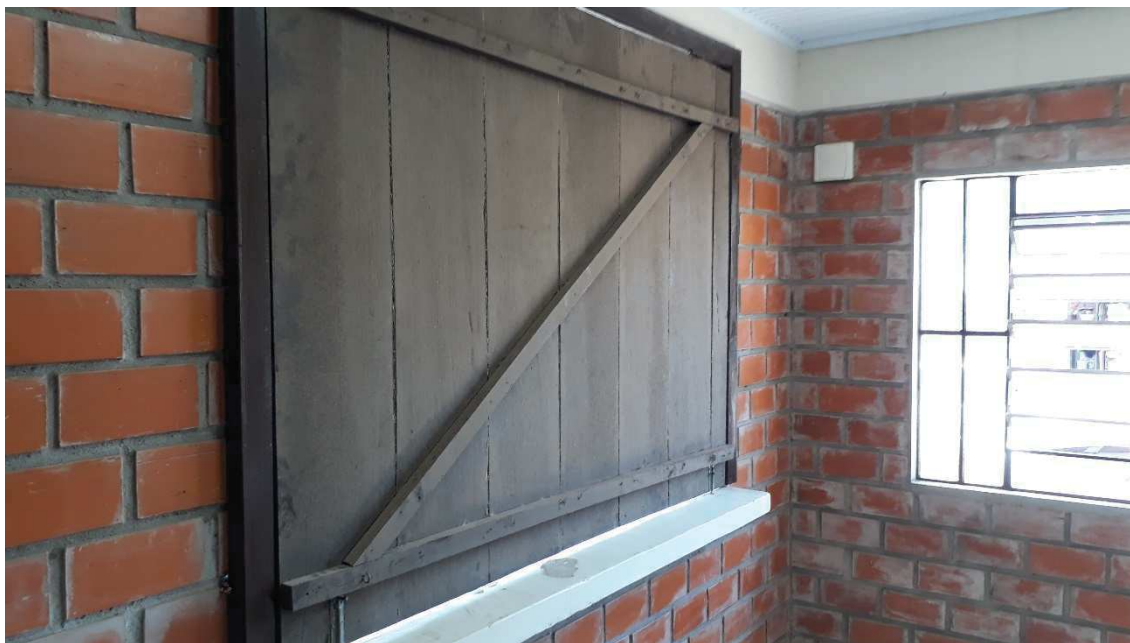
Janelas a serem substituídas (foto tirada em 09/12/2019).
