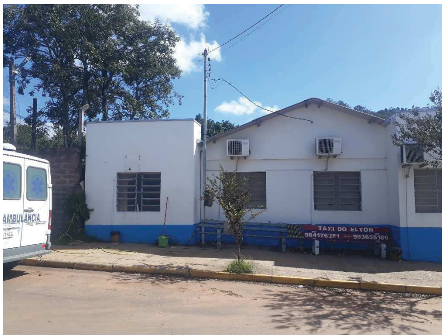
Foto 1 – Fachada a ser alterado o oitão.
