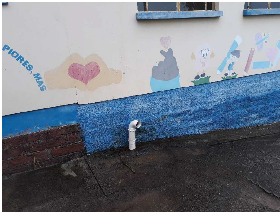
Foto 8 – Local a ser repostado o “Tubo de Queda” em PVC (foto tirada em 03/02/2021).
