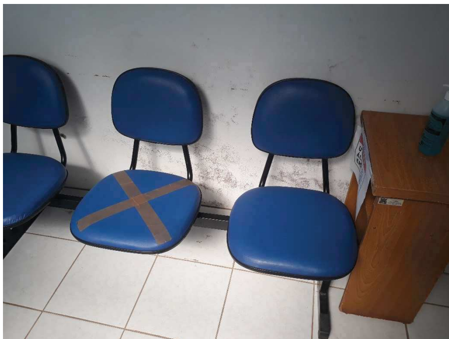
Foto 7 – Parede a ser preparada e pintada.
