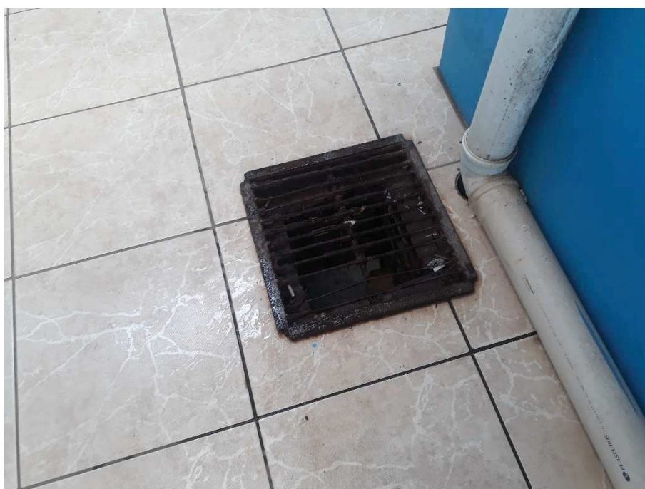
Foto 4 – “Caixa de Passagem” água pluviais.
