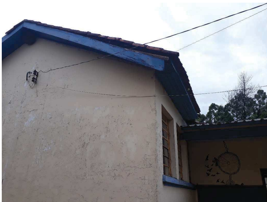
Foto 2 – Beiral da escola a ser reformado (foto tirada em 03/02/2021).
