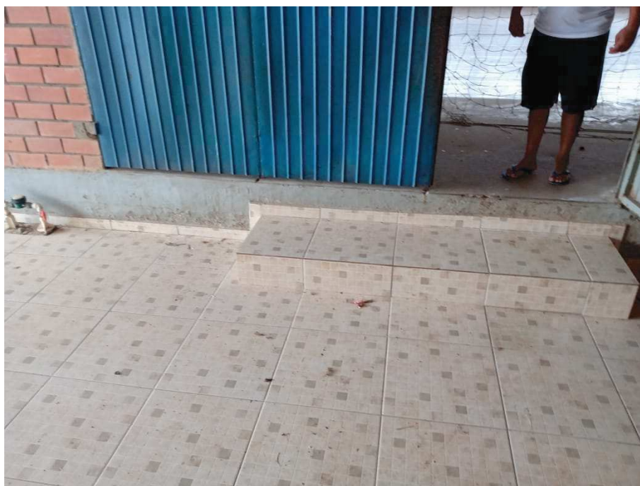
Foto 33 – Local a ser construída rampa de acesso ao ginásio (foto tirada em 03/02/2021).
