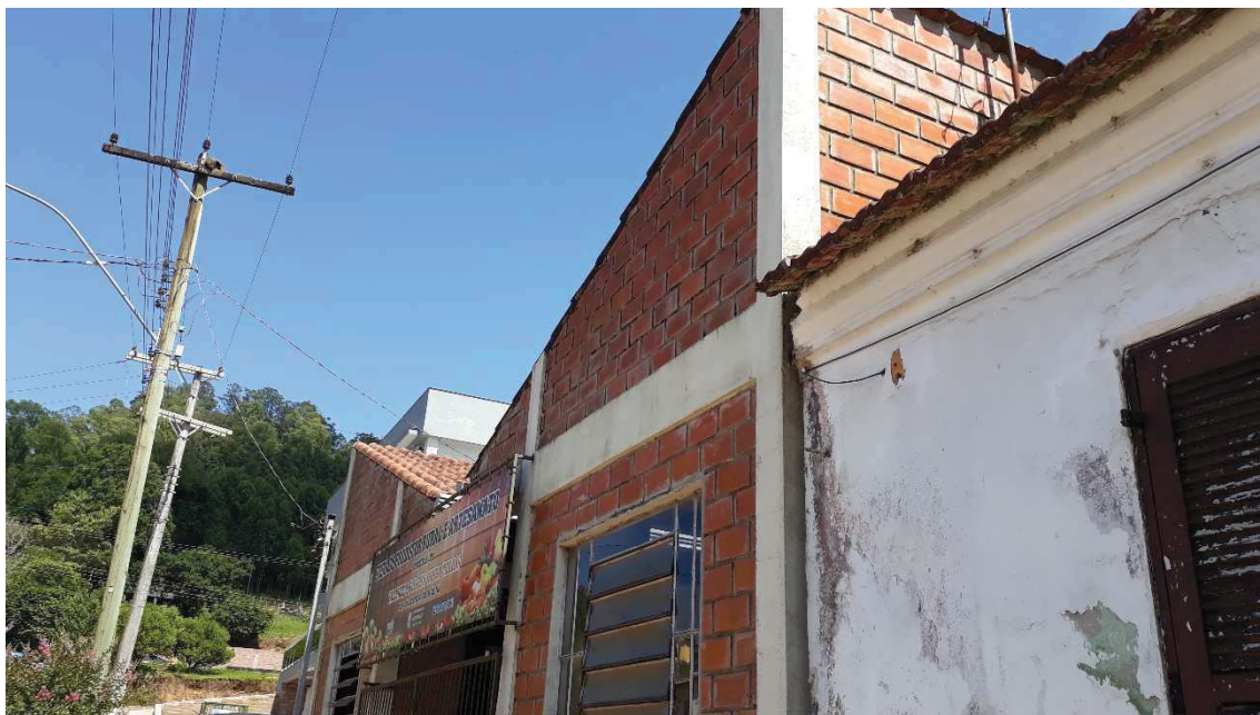
Paredes externas a serem pintadas (foto tirada em 09/12/2019).
