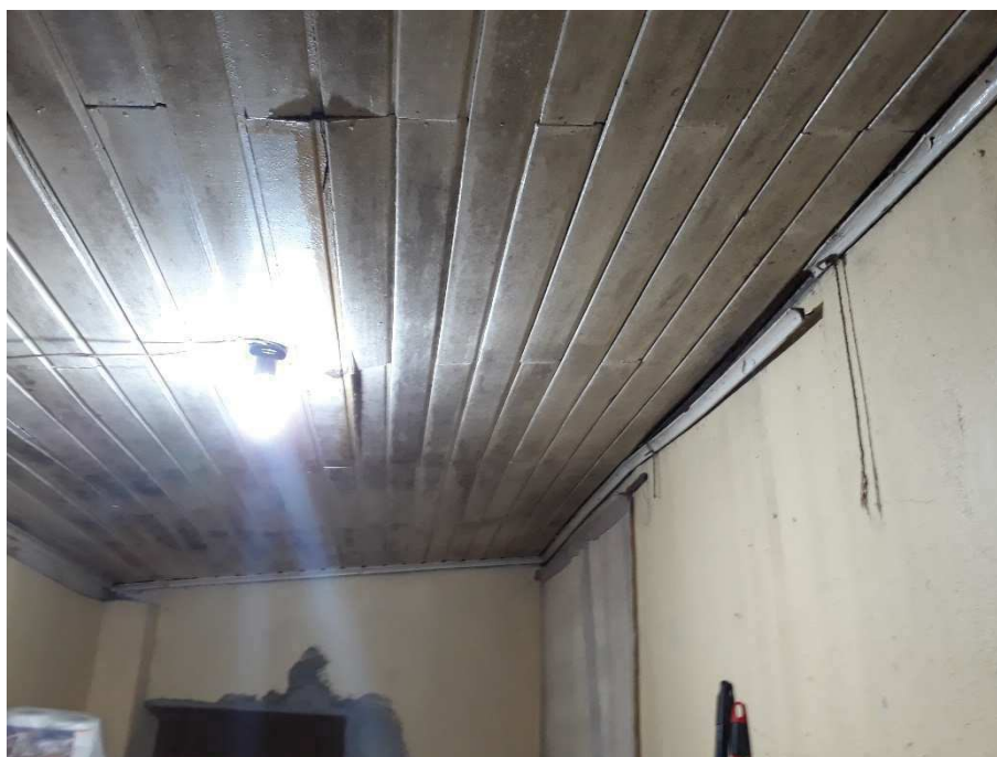
Foto 16 – Fôrro da escola a ser fixado e pintado (foto tirada em 03/02/2021).
