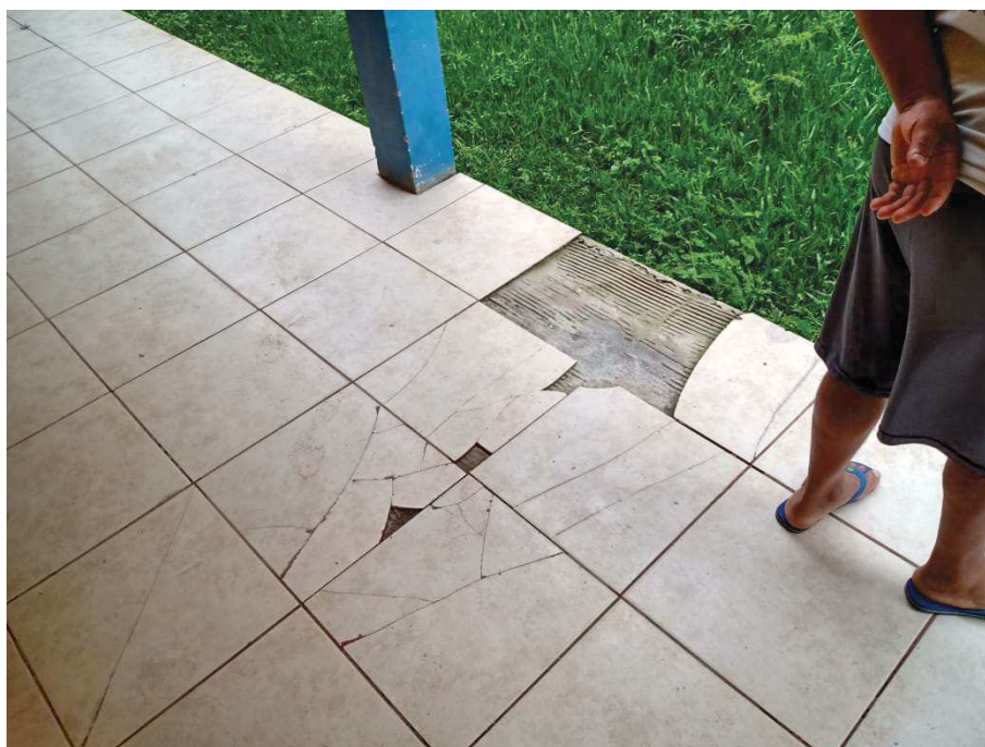
Foto 36 – Local a ser substituído o piso cerâmico (foto tirada em 03/02/2021).
