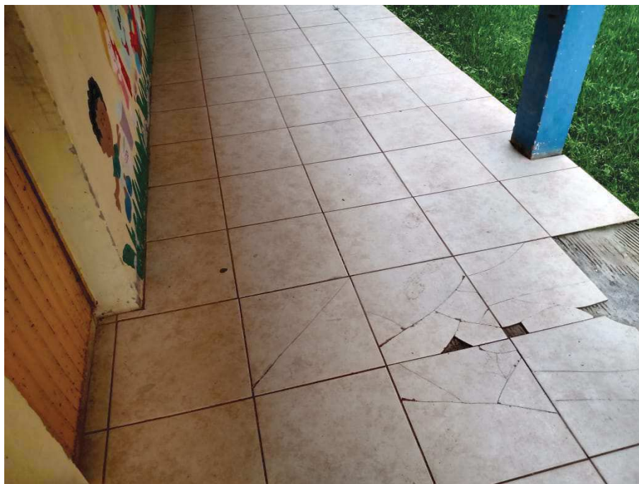
Foto 35 – Local a ser substituído o piso cerâmico (foto tirada em 03/02/2021).
