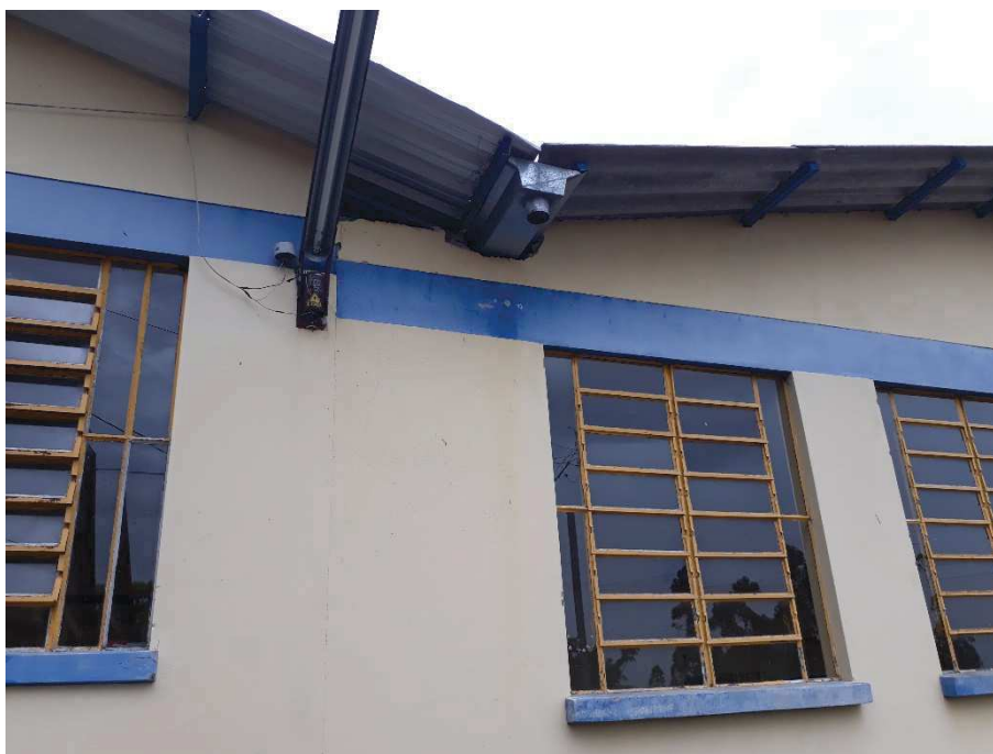
Foto 7 – Local a ser repostado o “Tubo de Queda” em PVC (foto tirada em 03/02/2021).
