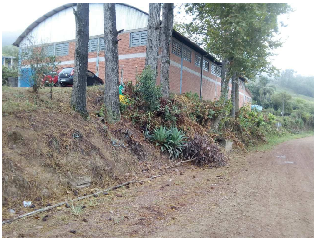
Foto 2 – Local do final da rede de distribuição do Trecho 2 e interligação com a rede existente de linha Herval – São João (coordenadas Lat. 29°28'45.75"S; Long. 52°38'58.62"O).
