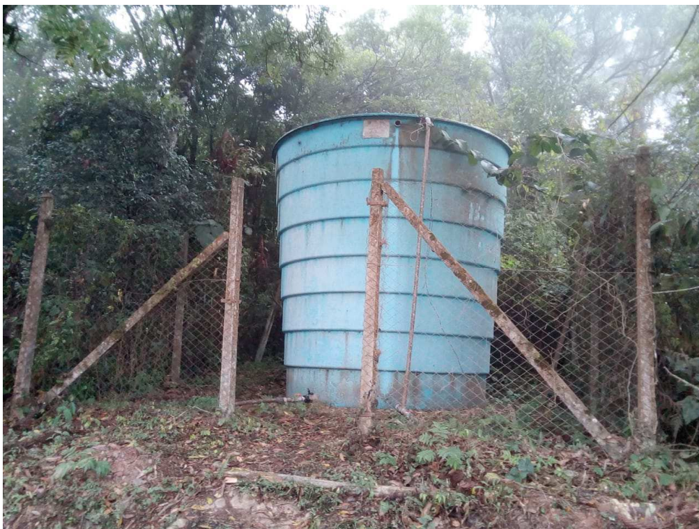
Foto 3 – Local do reservatório superior existente
