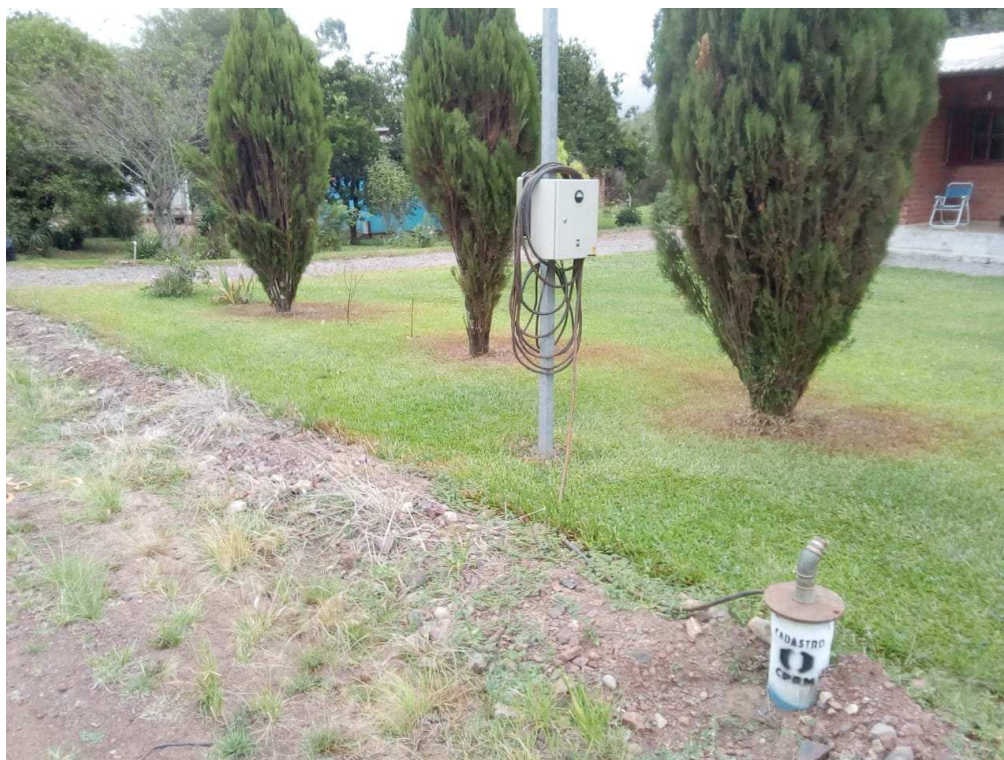
Foto 1 – Local do Poço Existente (coordenadas Lat. 29°28'44.05"S; Long. 52°40'14.86"O).
